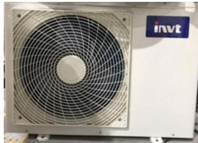
Оба вида прецизионных кондиционеров представляют собой инверторный кондиционер постоянного тока с DC инверторным компрессором, электро-коммутируемым вентилятором, электронным расширительным клапаном и плавно регулируемый наружным вентилятором (для модели сплит-системы).
